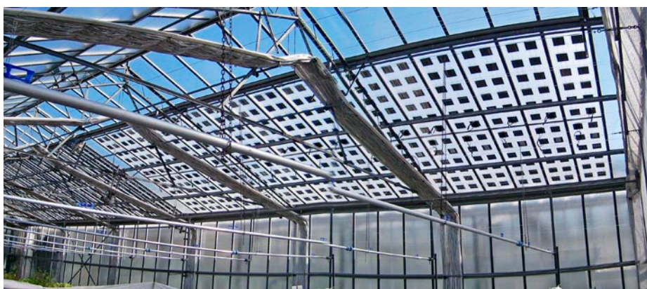
Foto 1 Nelle serre fotovoltaiche, distanziando le celle di silicio dei moduli, è possibile regolare la quantità di radiazione solare intercettata
